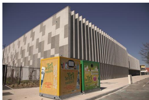
Dispositif aérien pour les recyclables Territoire Istres Ouest Provence
