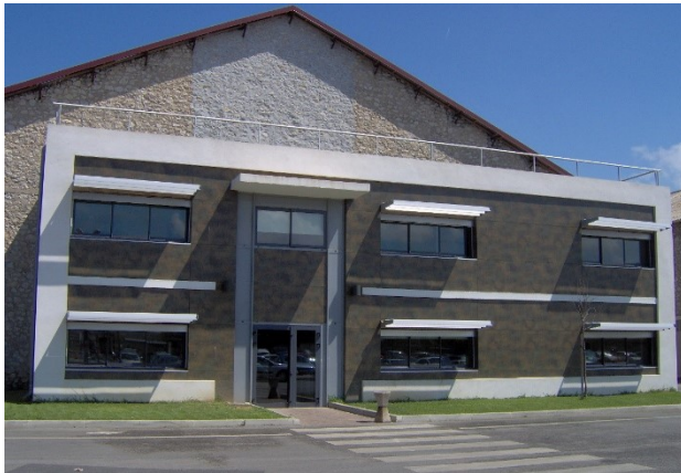
Bâtiment d'exploitation du service Collecte et Traitement des déchets
