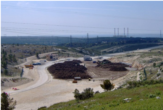
Plateforme de compostage en exploitation
