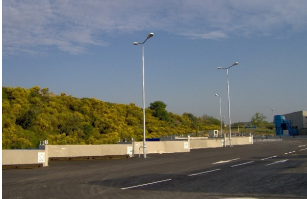
Haut de quais Déchèterie de Croix-Sainte
