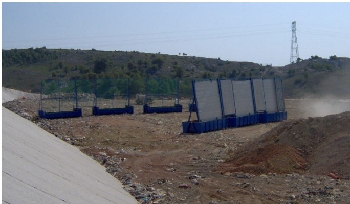
Bennes pare-vent et anti-envol sur le casier en exploitation
