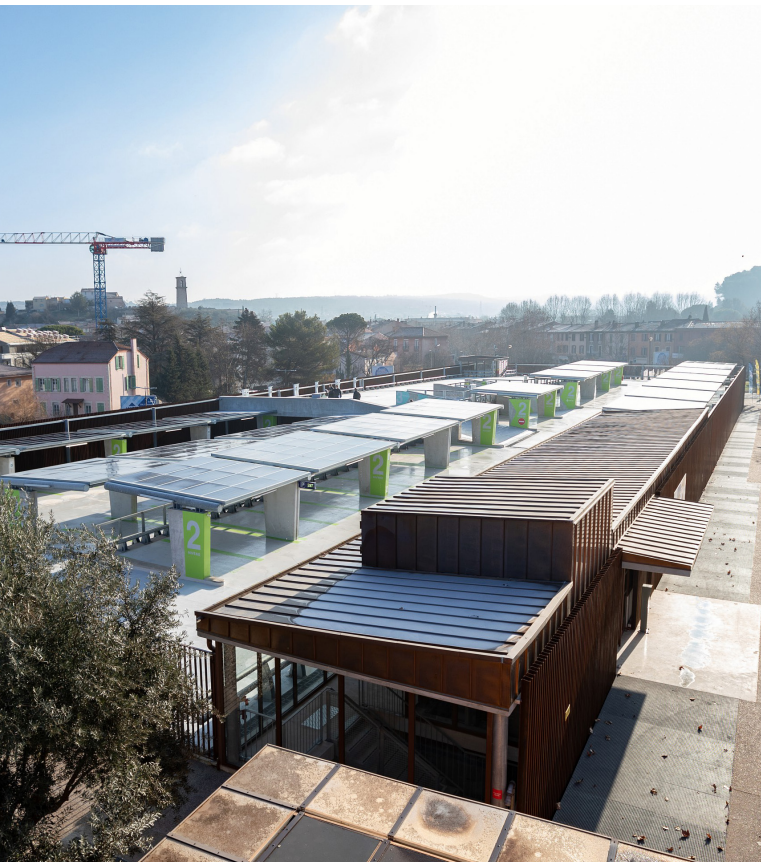
Pôle d'échange multimodal de Gardanne
