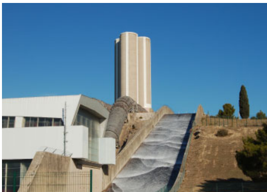
CENTRALE HYDROÉLECTRIQUE DE SAINT-CHAMAS
