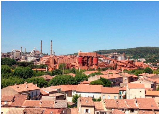
CENTRALE THERMIQUE, GARDANNE
