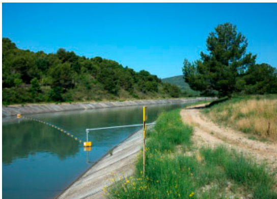
CANAL EDF, LE PUY-SAINTE-RÉPARADE
