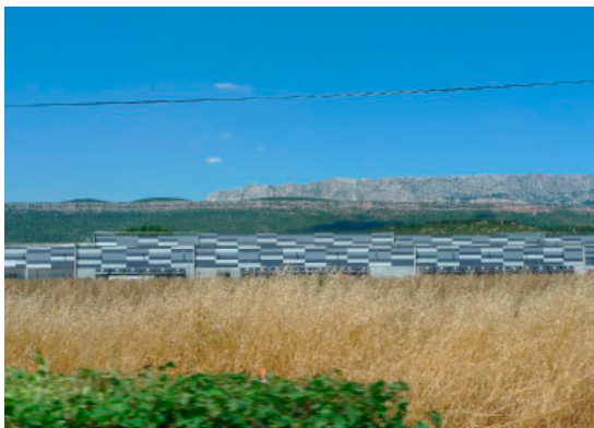
PLATEFORME LOGISTIQUE À ROUSSET
