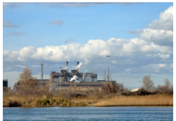
SITE SIDÉRURGIQUE D'ARCELOR MITTAL, FOS-SUR-MER © J BELVISI
