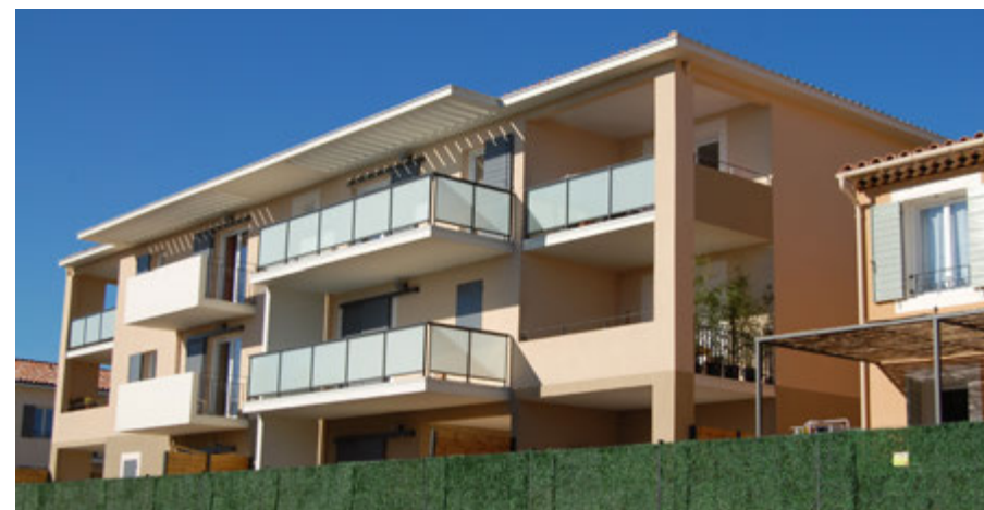
Une opération récente d'habitat collectif (Coudoux)
