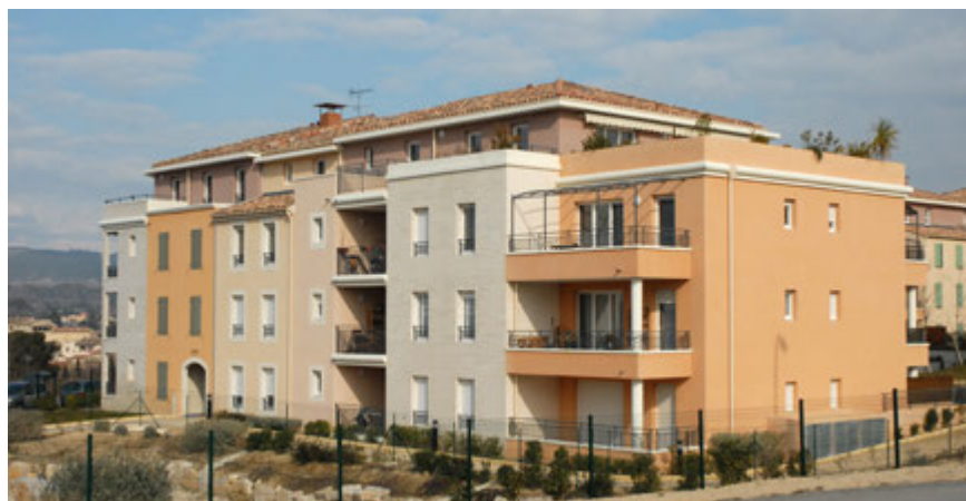
Une opération récente d'habitat collectif (Lambesc)
