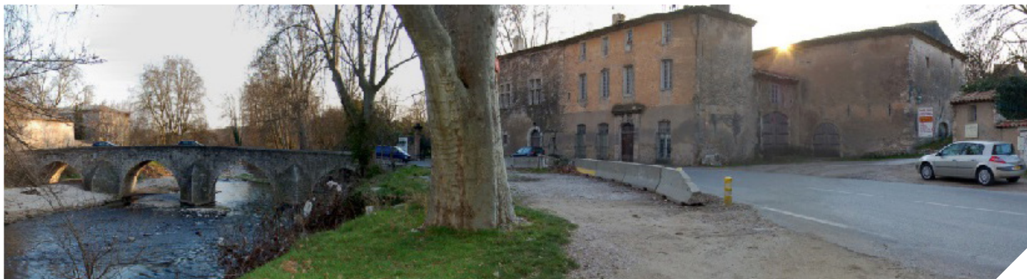
Pont de Saint-Pons sur les rives de l'Arc (Aix-en-Provence) : Classé monument historique par arrêté du 16 juin 1944, cet édifice en maçonnerie (45 m de long - 6 m de large - 4 arches) a été construit au début du XIVe siècle, un droit de passage y était perçu jusqu'en 1674.
