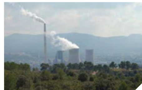
La centrale thermique de Meyreuil: ses cheminées et leur panache de fumées et vapeurs blanches ...
