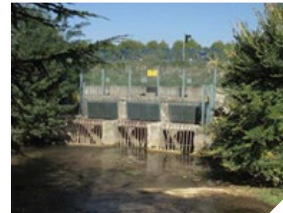
Déversoir sur l'Abbéou, St.-Paul-lès-Durance
