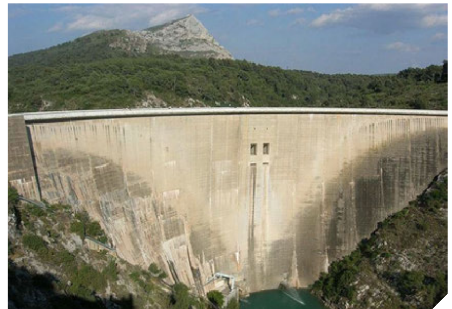
Le barrage de Bimont
