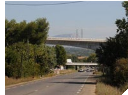
D10, Viaduc de Ponteil (LGV) et A8, Ventabren
