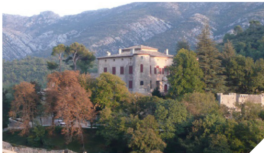
Château Picasso (Vauvenargues) depuis la D10
