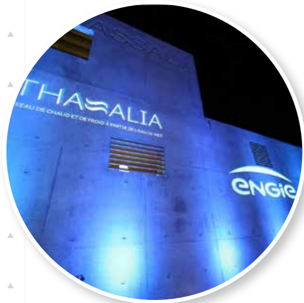
▲ Thassalia : un projet de centrale de géothermie marine porté par Engie.
