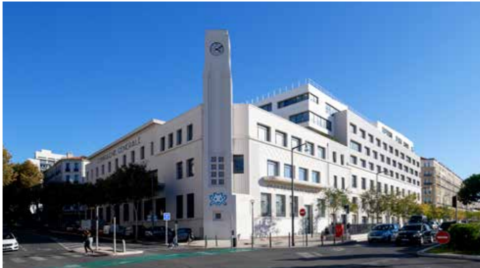
◀ La Cité de l'Innovation et des Savoirs Aix-Marseille (CISAM), dans l'ancien siège de la Compagnie Générale Transatlantique et de la SNCM, bâtiment art-déco classé.
