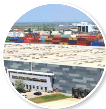
▲ Entrepôts XXL en marge du port de Fos-sur-Mer
