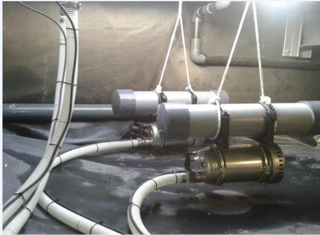
Vue des pompes Drenag et flotteurs
