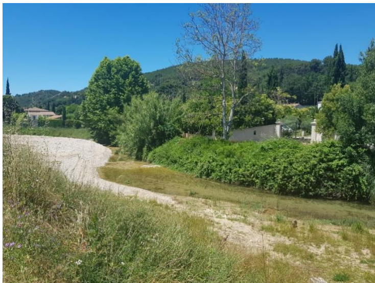
Figure 8 : L'Huveaune au parc de la confluence à Auriol, secteur restauré dans le cadre de la phase 1 de Contrat de Rivière ; création d'une zone d'expansion des crues et renaturation des berges
