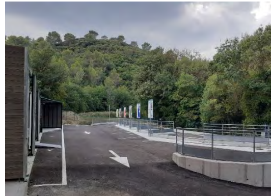
Haut de quais de la déchèterie Commune de Vauvenargues
