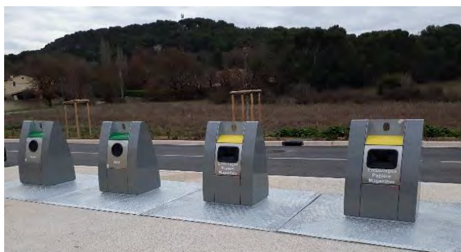
Dispositif enterré Commune de Cabriès
