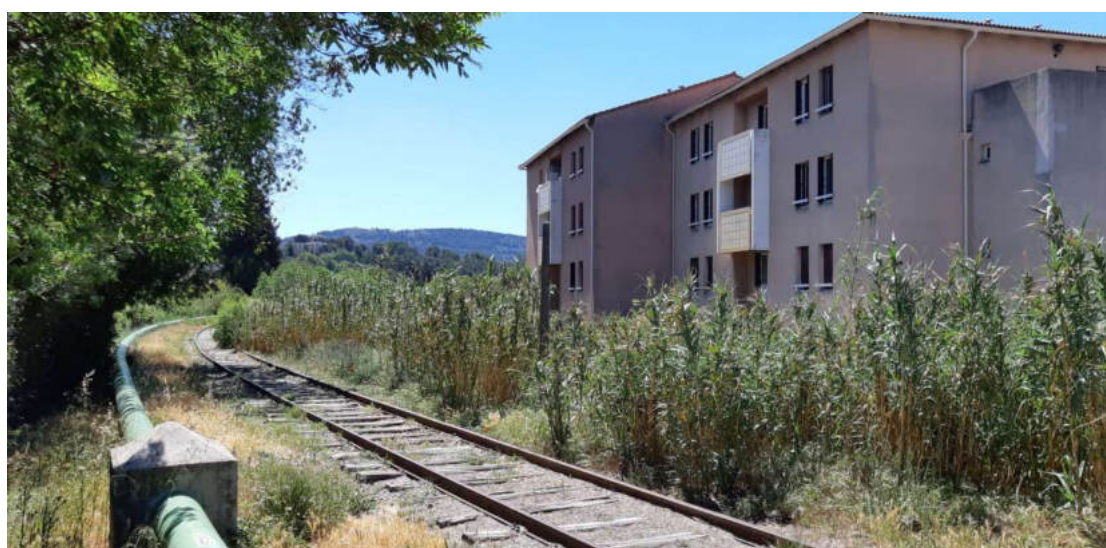
Vue de la canalisation ALTEO, le long de la voie au niveau de la campagne Valérie
