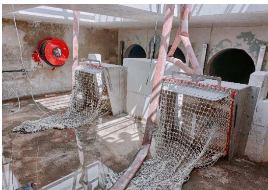
Photo : Pôle Protection du Cycle de l'Eau - Travaux au Roucas
