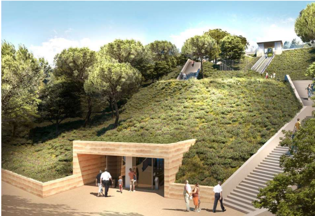
Ascenseurs inclinés en gare SNCF de Vitrolles Aéroport Marseille Provence © STOA - Groupement POMA / EIFFAGE / STOA / INGEROP
