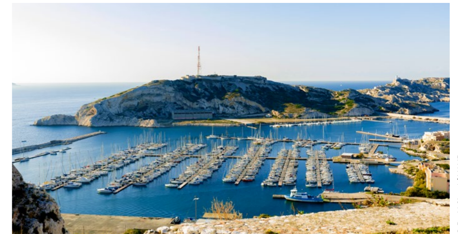
Port du Frioul, Marseille.
