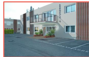
ONET SERVICES 2 332 m 2 Vitrolles Aéropole Rénové – 135€/m 2 /an HT HC
