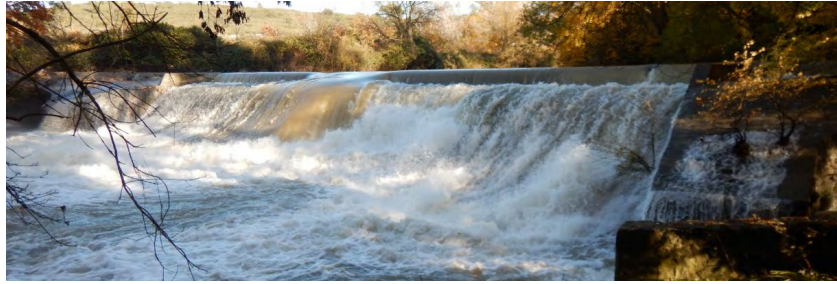
Seuil de Roquefavour sur l'Arc (source EPAGE MENELIK)
