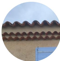
Double rang de génoise sur l'édifice principal, un seul sur le bâti secondaire. Les couvertures à deux pans sont garnies de tuiles canal.
