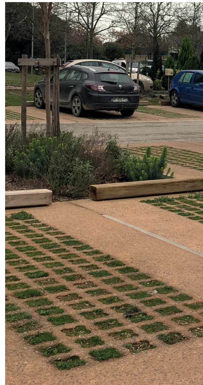
Parking perméable - Village des marques Miramas
