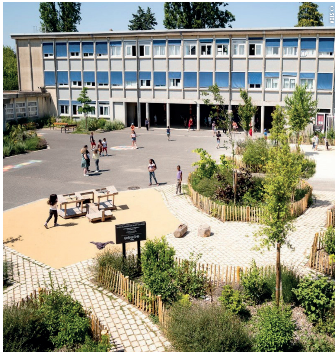
Opération de désimperméabilisation d'une cour d'école
