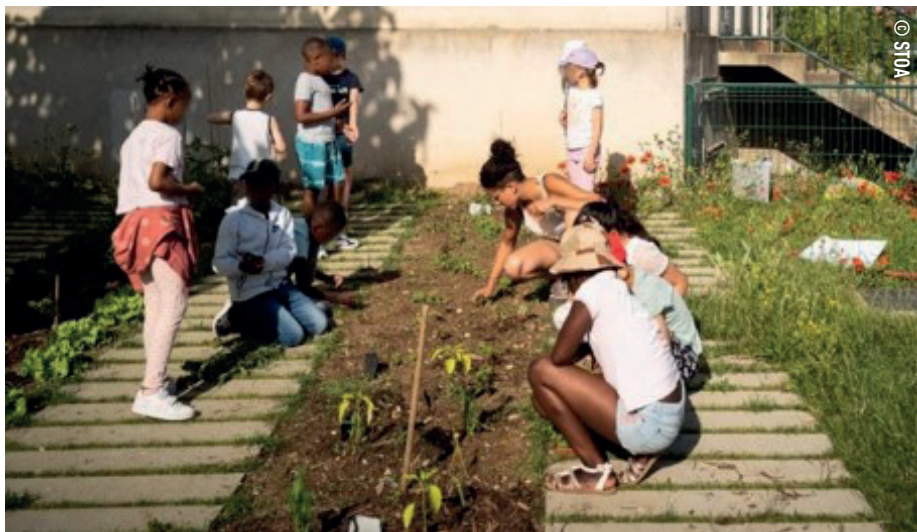
Opération de désimperméabilisation d'une cour d'école
