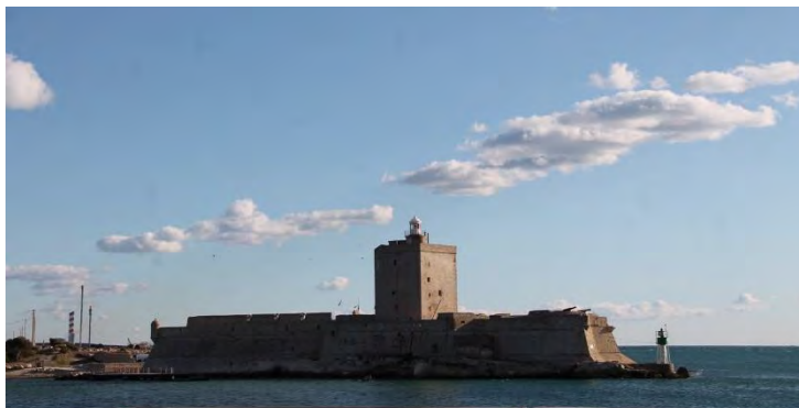
Fort de Bouc - Martigues
