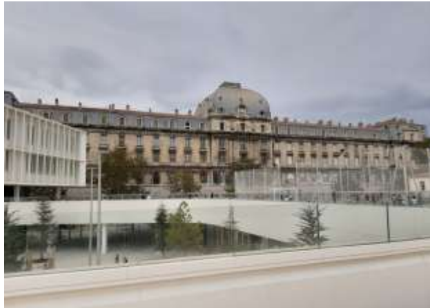
Groupe scolaire Simone de Beauvoir
