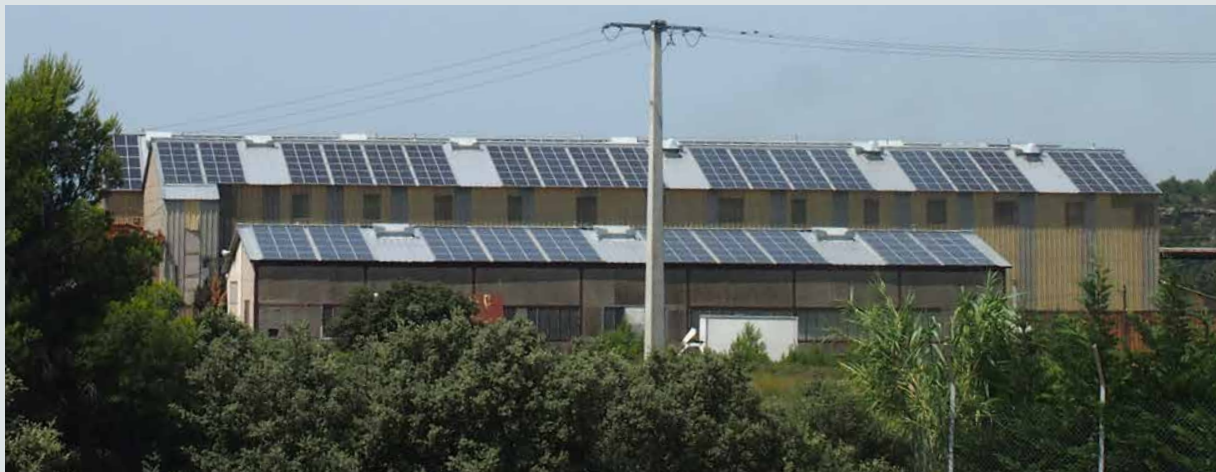
TOITURE PHOTOVOLTAÏQUE SUR HANGAR AGRICOLE – SAINT CHAMAS. © Crédit Agam
