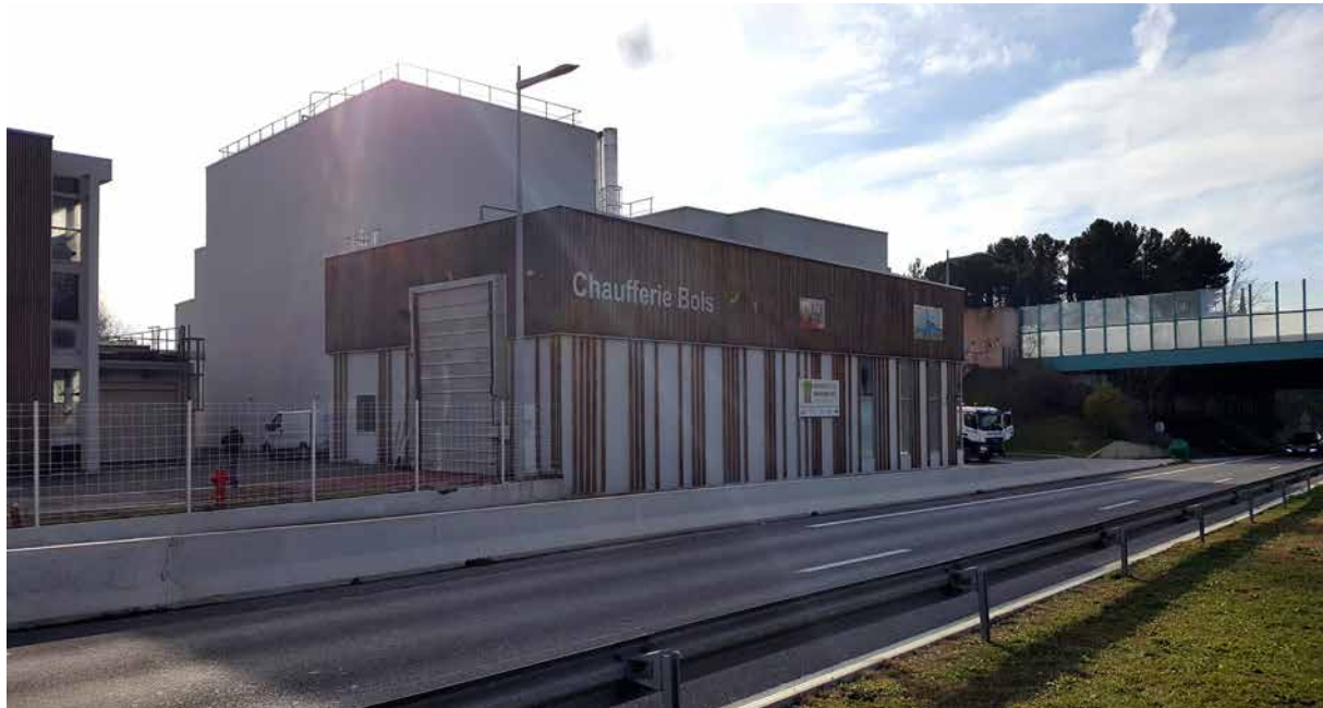
CHAUFFERIE BOIS ALIMENTANT LE RÉSEAU DE CHALEUR D'AIX-EN-PROVENCE. Source : APEE
