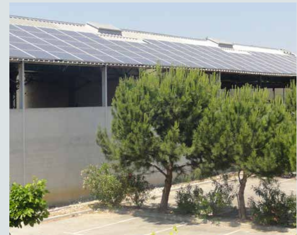
TOITURE PHOTOVOLTAÏQUE SUR HANGAR PROFESSIONNEL – MARSEILLE - SAINT MARCEL . © Crédit Agam
